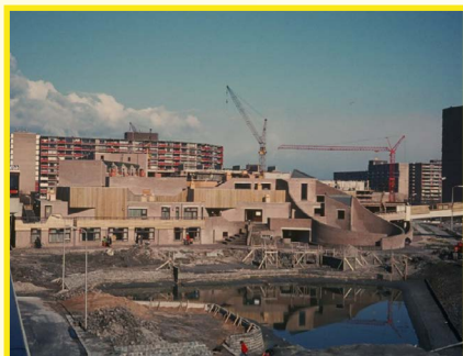
Het wijkcentrum in aanbouw, 1975
