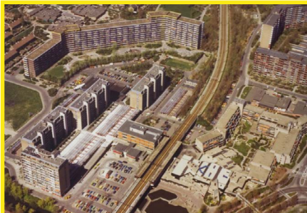
Luchtfoto van het centrum Meerzicht in 1984
